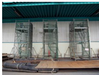
散水台 (改善前: 屋根なし)
